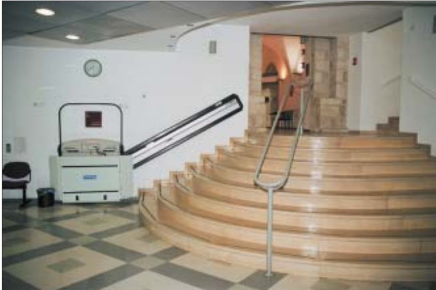
מדרגות כניסה ("בית הקשתות" ששופץ לאחרונה עם דגש על היבטי בטיחות). לאורך שולי המדרגות הודבקו סרטים להגנה מפני החלקה. לאורך הקיר הותקן "מעלון" לנגישות של נכים
