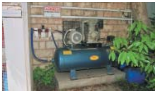
מדחס מוצב מחוץ למבנה, במקום נגיש, נקי ומסודר, עם הגנות על כל החלקים הנעים
