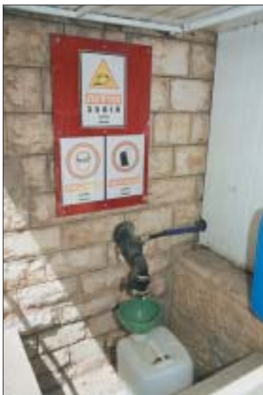
מאצרה ייעודית לחומצות המשמשות בסדנת הדפוס (לפיתוח לוחות לדפוס). סילוק החומצות נעשה באמצעות צנרת ייעודית לתוך מיכל המוצב במאצרה
