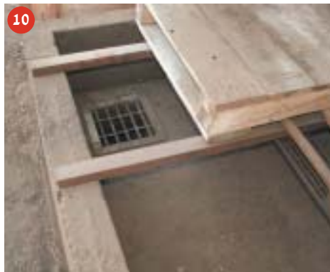
9, 10. עמדת תידלוק המלגוזות מותקנת במאצרה עם מאגר איסוף תת-קרקעי
