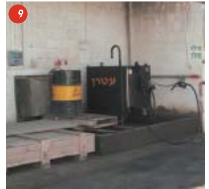
9, 10. עמדת תידלוק המלגוזות מותקנת במאצרה עם מאגר איסוף תת-קרקעי
