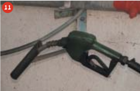
11. ידית התדלוק לא בשימוש, מונחת בתוך תושבת חלולה מעל למאצרה
