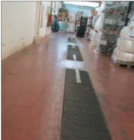
מעבר ראשי עם פתחי ניקוז מרושתים המנקזים שפך ונוזלים לתוך מאצרה הטמונה מתחת לרצפה
