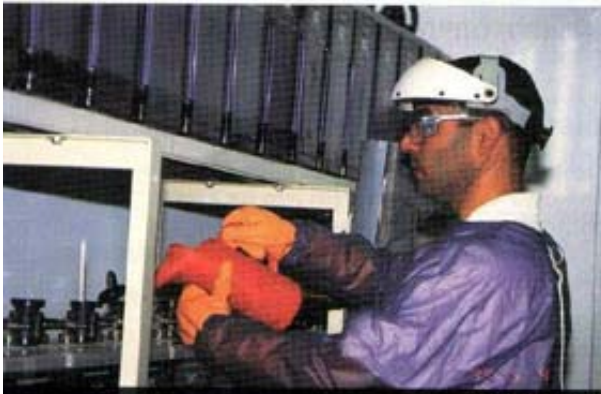
תחזוקת מצברים: מילוי מים מזוקקים. העובד מוגן בציוד המגן האישי המתאים (באדיבות 'פאזה אחרת', גליון 72)
