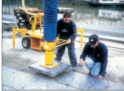
העברה והנחה של רכיבי מדרכה באמצעות ציוד ואקום (מתוך 'Chantier BTP', צרפת, גיליון מאי 2000)
