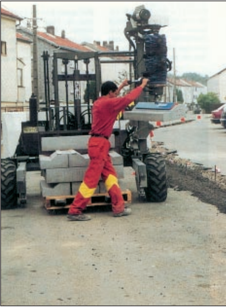
העברה והנחה של רכיבי מדרכה באמצעות ציוד ואקום (מתוך 'Chantier BTP', צרפת, גיליון מאי 2000)
