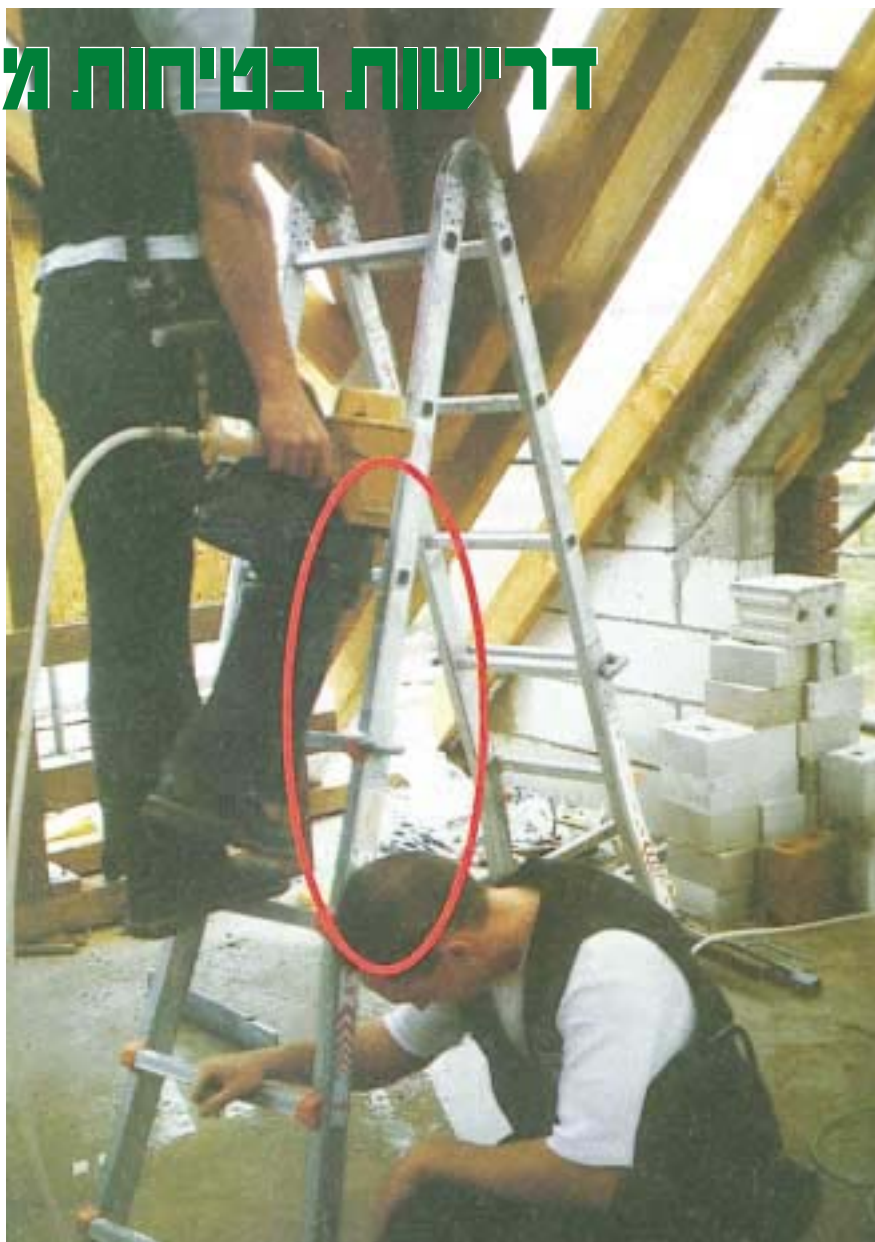
שיחזור התאונה: עובד עלה על סולם כפול כדי לחזק קורת עץ באמצעות אקדח מסמרים המופעל במגע
