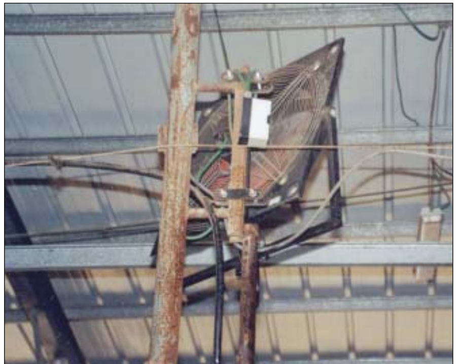
מאוורר עילי לתחלופת אוויר ולצינון (באמצעות ממטירי מים המפוזרים מתחת לגג. תנועת האוויר המאולצת מפזרת את הטיפות בחלל)
