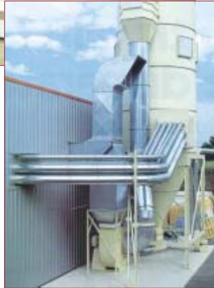
מערכת שאיבה מרכזית. למעלה: צנרת איסוף מותקנת על פתחי שאיבה במכונה. מימין: "ציקלון" שאליו מועבר האבק באמצעות תעלות האיסוף
