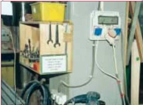
לוח זה מחובר דרך מפסק מגן לזרם דלף (מימסר פחת) ולפיכך - מותר להזין באמצעותו כלים מיטלטלים
