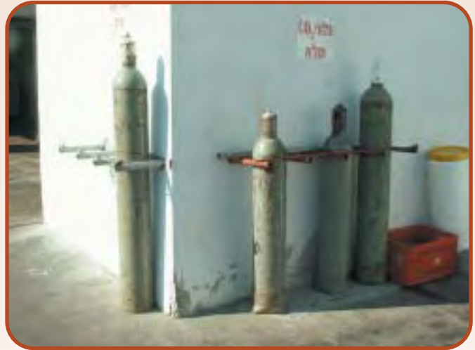
עמדות אחסנת מיכלי גז דחוס (CO 2 ) המשמשים להכנת מי סודה אצל הצרכנים - הפרדה בין מיכלים מלאים וריקים
