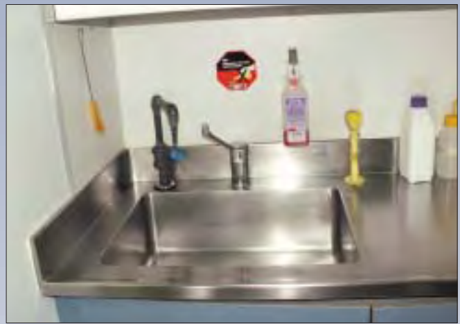
כיוור לשטיפת כלים וידיים עם התקני בטיחות: מישטחי נירוסטה לניקיון מירבי, ברז ומיתקן סבון לפתיחה ולהפעלה באמצעות אמת היד, מיתקן שטיפה ידני לעיניים, שילוט אזהרה מפני שפיכה בלתי מבוקרת לכיוור
