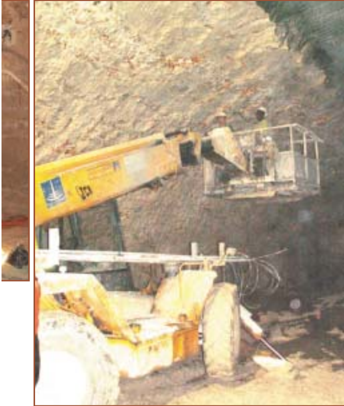
עבודות הכנה לתימוך דופן מנהרת החלוץ
