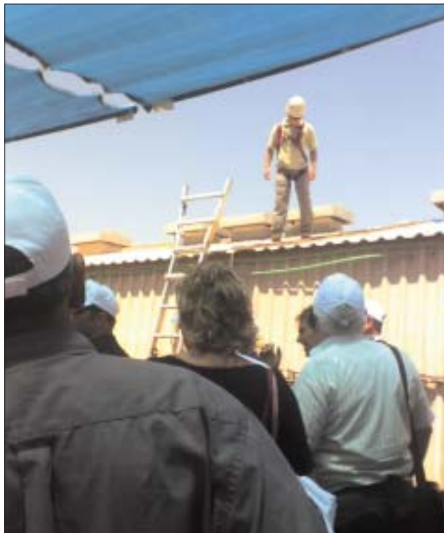
עובד רתום בריתמת בטיחות הולך לאורך "סולם זחילה", קשור לאלמנט כלשהו על הגג (כנראה פתחי איורור)
