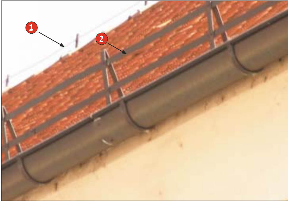
גג רעפים: (1) "קו חיים" מאפשר חיבור אמצעי קשירה לכל אורכו (2) מעקה לאורך שפת הגג מונע נפילה למטה בעקבות החלקה
