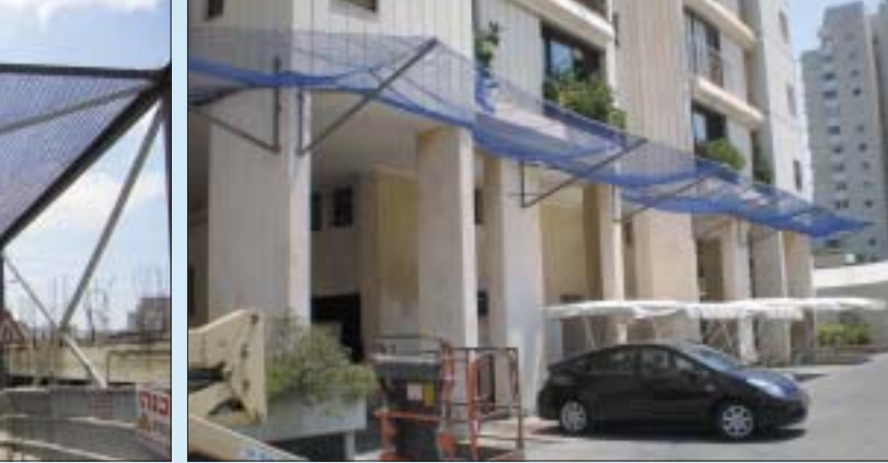
הרשת המורכבת על מסגרות זיזיות סביב הבניין מגינה מפני חפצים נופלים על כל מה שנמצא מתחתיה
