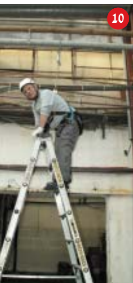
העובד מאובטח ברמתה ובאמצעי קשירה המעוגן לצינור יציב בעבודה מעל סולם גבוה
