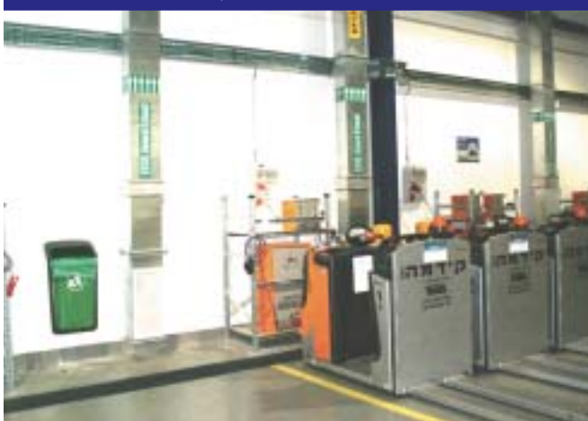
תמונה 17: מערכות שאיבת גזים מותקנות בעמודי שאיבה מול המלגוזות שבטעינה
