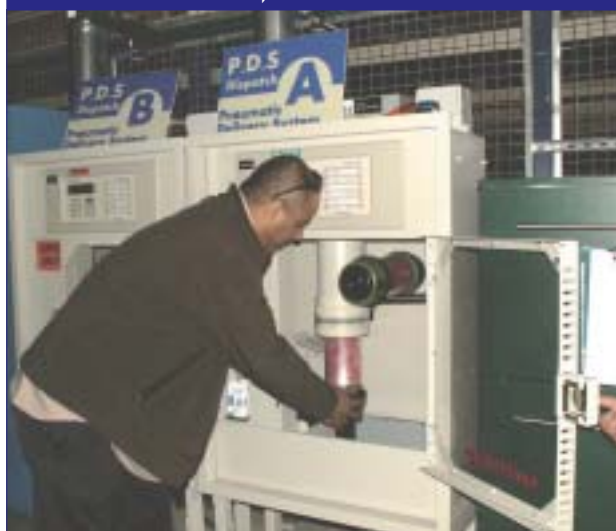
תמונה 3: הטענת גליל משלוח לתוך המערכת הפניאומטית
