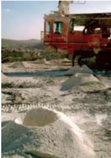
תמונה 2ב': מכונת הקידוח והקדחים הממתינים למילוי
