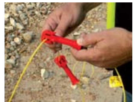
תמונה 6: חיבור שרשרת הפיצוץ באמצעות הקליפסים הנפצים
