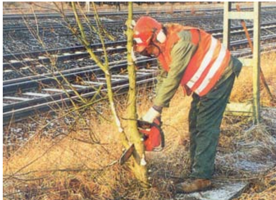
תמונה 1: בזמן הניסור יש לאחוז את המסור כל הזמן בשתי ידיים. המרפק השמאלי צריך להיות נוקשה. במצב זה קל יותר למנוע פגיעה במפעיל במקרה של רתיעה לאחור. בכל מקרה יש להגן על הראש, הפנים והאזניים
