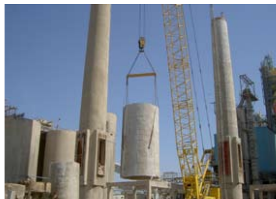
הורדת המיקטע המנוסר לקרקע לפני הריסוק והגריסה
