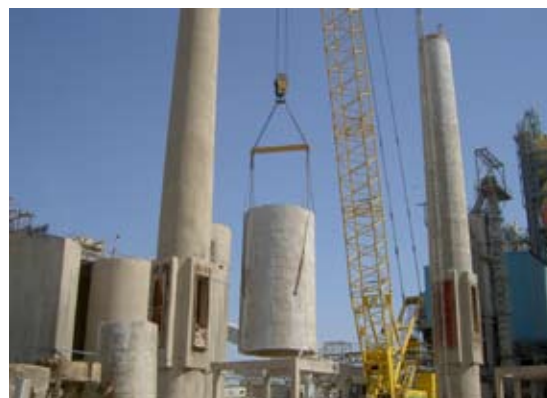
הורדת המיקטע המנוסר לקרקע לפני הריסוק והגריסה
