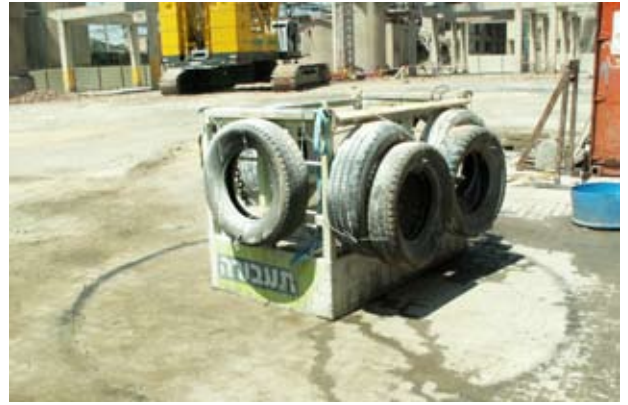
סל העבודה מרופד בצמיגים ישנים. המעגל המסומן על הקרקע (מתאים לקוטר הארובה) שימש לתייגול לעגורנאי בהכנסת הסל עם העובדים אל מרכז העיגול - לצורך שלשולו לתוך הארובה
