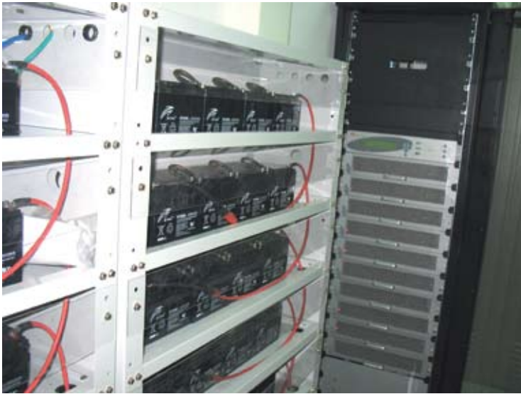
מיתקן מצברים חיצוני של מערכת אל-פסק תעשייתית גדולה (מימין)
