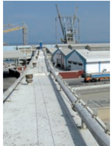
דגון בתי ממגורות: התקנת קווי חיים מעל אזור המסועים
