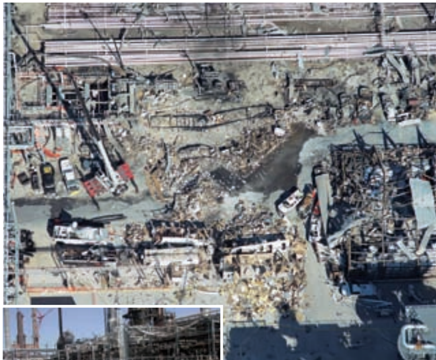
תאונה בבית הזיקוק של BP בטקסס ארה"ב שאירעה במוץ 2005: כתוצאה מהפיצוץ והשריפה שפרצה בעקבותיו היו 15 הרוגים ו-180 פצועים. מקור הפיצוץ היה רכב שעמד מונע בסמוך למתקן
