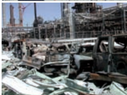
תאונה בבית הזיקוק של BP בטקסס ארה"ב שאירעה במוץ 2005: כתוצאה מהפיצוץ והשריפה שפרצה בעקבותיו היו 15 הרוגים ו-180 פצועים. מקור הפיצוץ היה רכב שעמד מונע בסמוך למתקן
