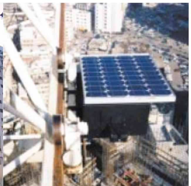
תמונה 3: מימין - פנל סולארי לאספקת אנרגיה נקייה וזמינה. משמאל - יציאה באזור נסתר מעיני העגורנאי, אך הוא רואה את סימני הידדים של היוצקים בעזרת המצלמה, ומגיב בהתאם
