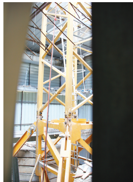
מנוף בתוך אתר הבנייה. בסיס המנוף מגודר, כדי למנוע כניסת עובדים לאזור מסוכן
