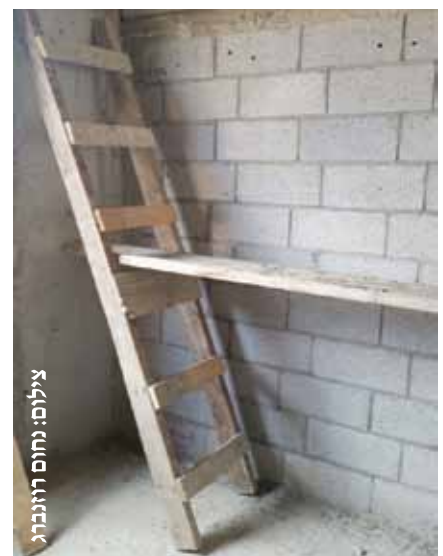
עובד עומד על סולם בצורה מסוכנת משטח עבודה מאולתר ומסוכן
