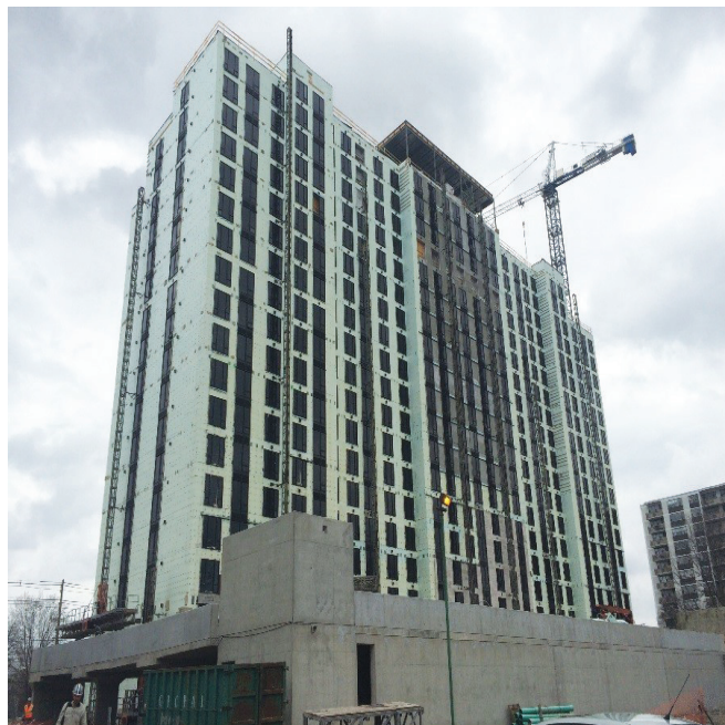
בניין של 19 קומות שנבנה בשיטה המתקדמת וללא עגורן. החברה שבונה בסמוך בשיטה הקונבנציונלית משתמשת בעגורן
