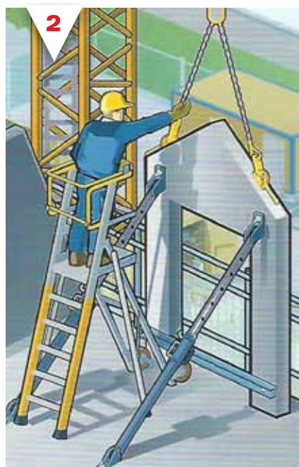
תמונה 2: קיבוע נכון של רכיב טרומי באמצעות 2 רגליים
