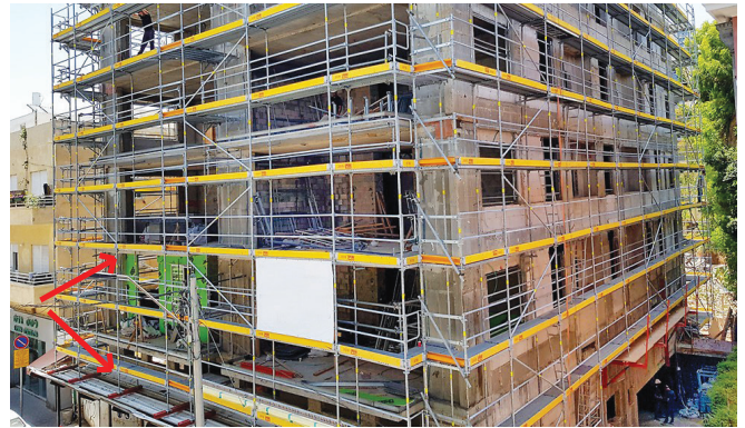
לוח רגל למניעת נפילת חפצים; למטה - גגון למעבר הולכי רגל
