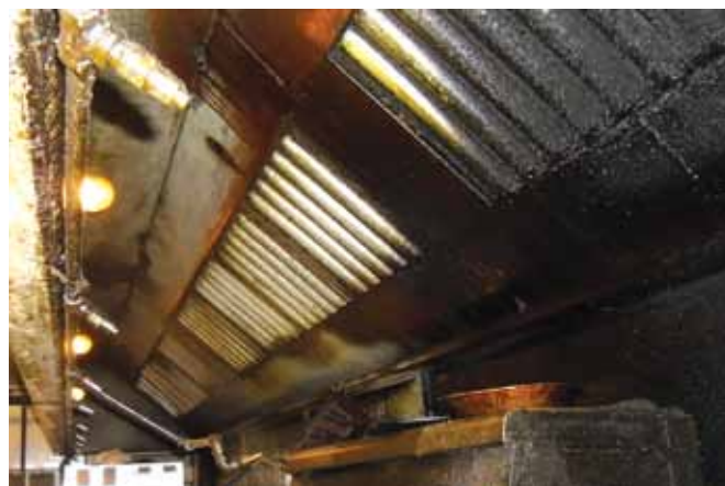
אירוע אש ידוע מראש בשל מינדף מוזנח. תעלת אוויר אופיינית למטבח עם טיגון עמוק עם מישקעים שומניים קשים להסרה ודליקים בטמפרטורה של 200^{\circ}\text{C} בלבד.
