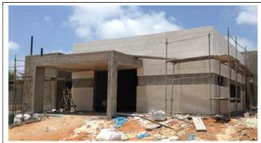
תמונה 9. פיגום זקפים עד גובה של 6 מטרים המוקם לצורך ביצוע עבודות בנייה בבניין צמוד קרקע (בנייה עצמית) ללא השגחה של בונה מקצועי לפיגומים.
