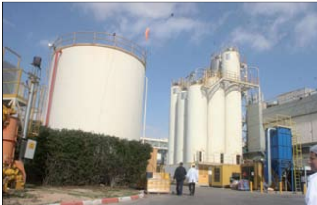
ממין חוות הסילואים המשמשות לאחסון סוגי קמח שונים. בכל סילו ניתן לאחסן בין 20 ל-30 טון חומר. משמאל – מאגר המים בתכולה של 500 קוב, המשמש לעיתות חירום, בעת הפעלת משאבות הכיבוי. בראש המיכל מתנוסס שק הרוח המסמן את כיוון הרוח בטיפול באירוע או בעת הנחתת מסוק בשעת חירום
