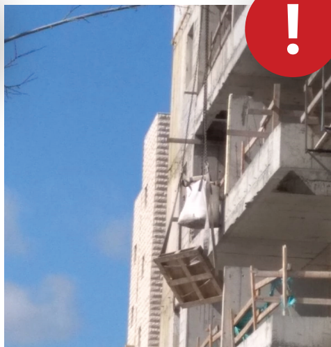
Неправильный и опасный подъём груза
