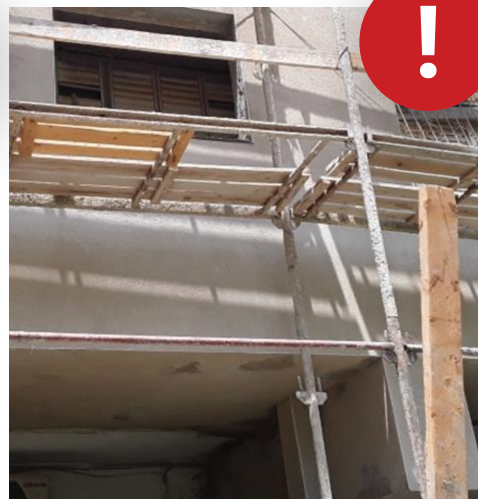
Неисправные строительные леса
