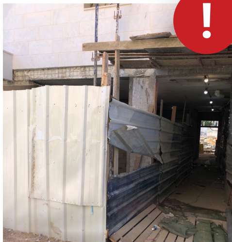
Неисправное ограждение строительной площадки
