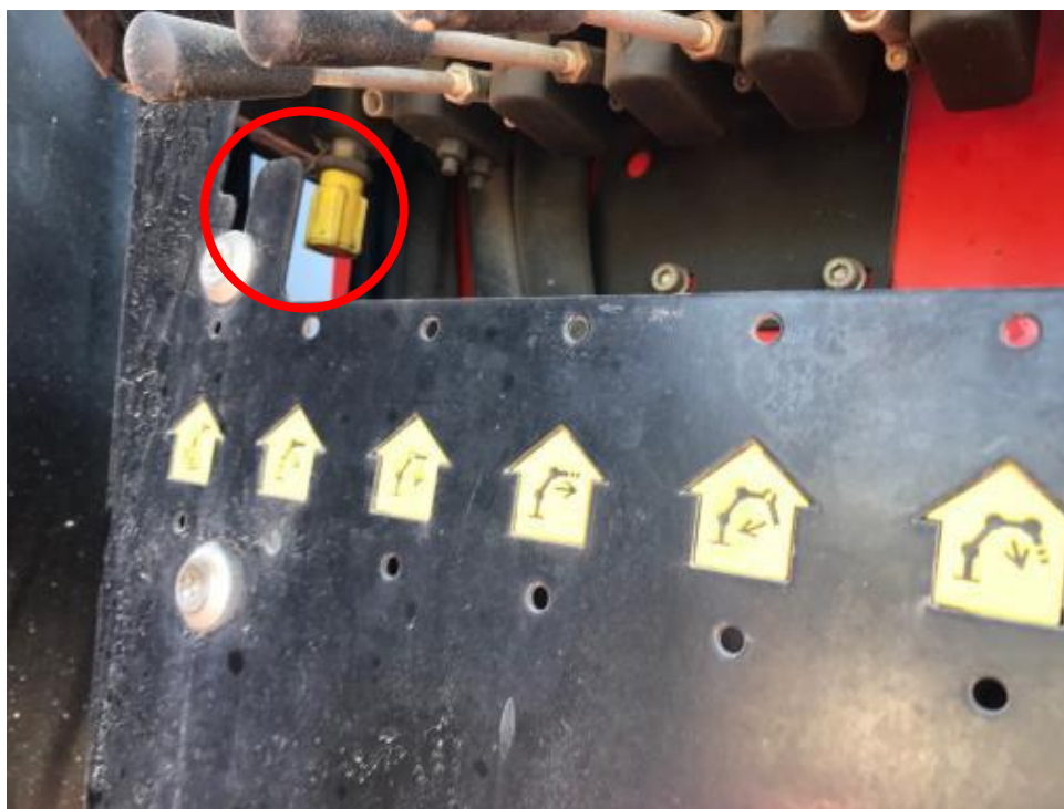
ברז העברה למוד חירום (ללא חותם) בעגרון תוצרת פלפינגר (מסומן בעיגול אדום)
