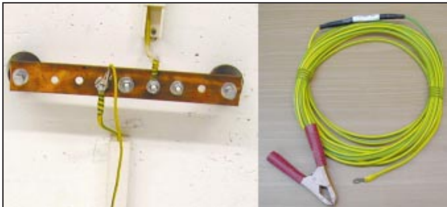
איור 41: מערך הארקה אלקטרוסטטי, הכולל נגד טורי ומרכזיית הארקה, לחיבור "גופים-חמים"
