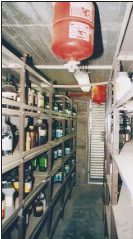
מחסן חומרים כימיים עם מיתקן אוטומטי לכיבוי אש המותקן בתוכו
