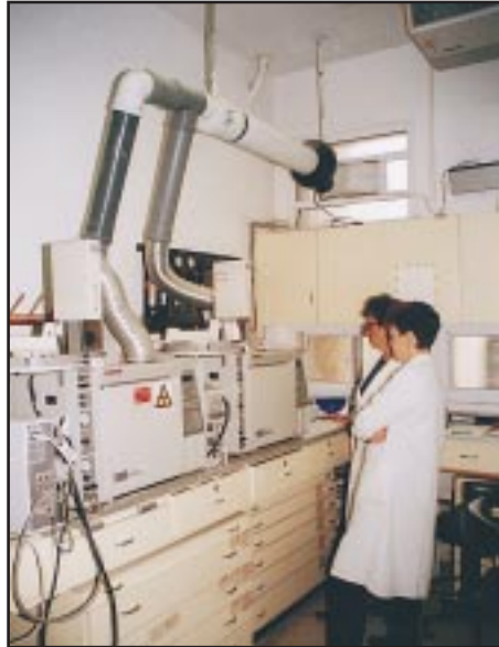
מערכת לאיוורור מקומי עבור מיתקנים במעבדה
