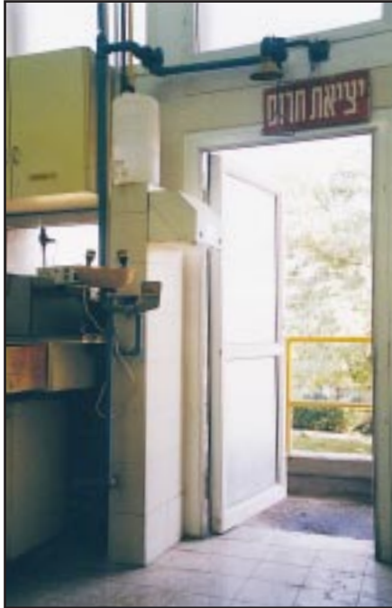
יציאת חירום יעילה (הדלת נפתחת כלפי חוץ. מקלחת ומשטפת עיניים מותקנים בסמוך אליה)
