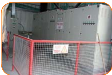
▲ אזור מגודר במפעל הייצור. גידור והגנה של לוח חשמל ראשי במפעל לייצור חלקי בטון טרומי
