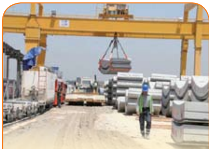
▲ עגורן גשר באזור פורטל המנהרה. מהמפעל מוסעים אלמנטי הבטון הטרומי אל מערום הנמצא בפורטל המנהרה, משם אלה מועמסים באמצעות עגורן גשר על קרונות הרכבת המובילות אותם להתקנה
